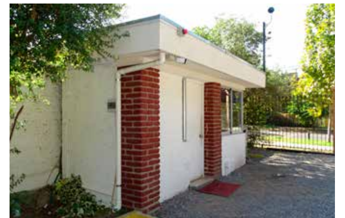
Remodelación de la caseta de vigilancia. Acceso vehicular
