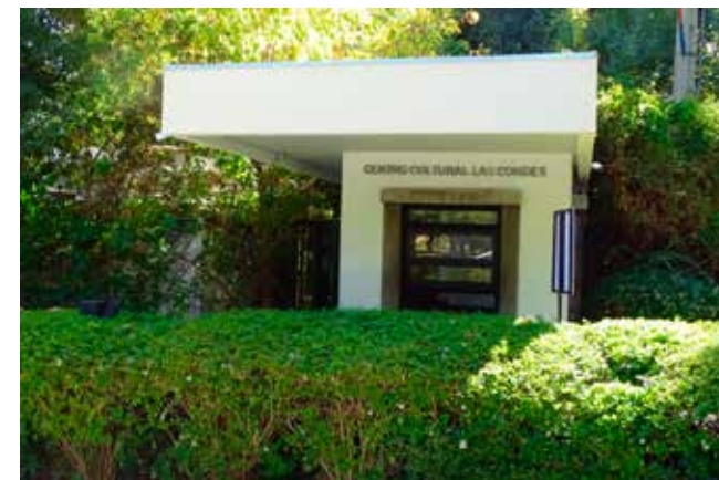
Remodelación de la caseta de vigilancia. Acceso principal
