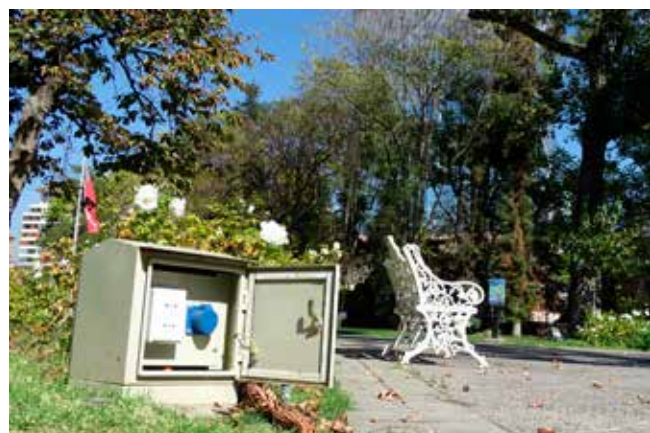
Instalación de sistema de energía en explanada principal
