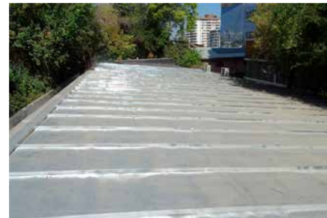
Reparación de la cubierta sur del pabellón de salas de clase
