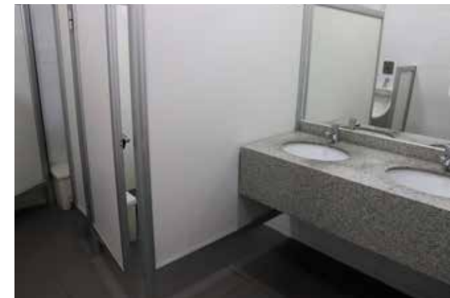
Remodelación de baños públicos
