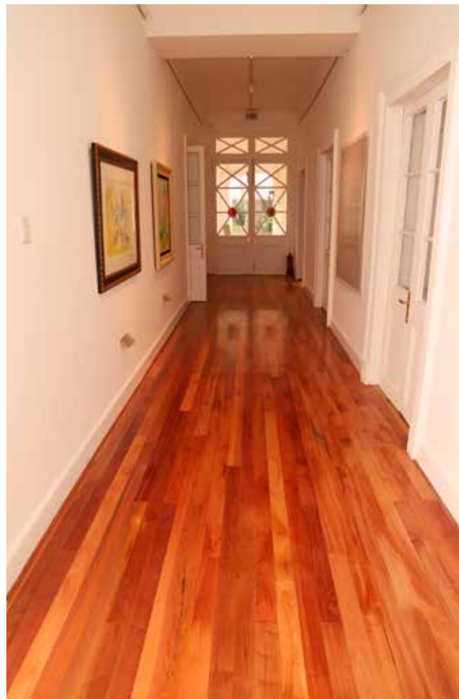
Restauración piso de madera de pasillo Casona
