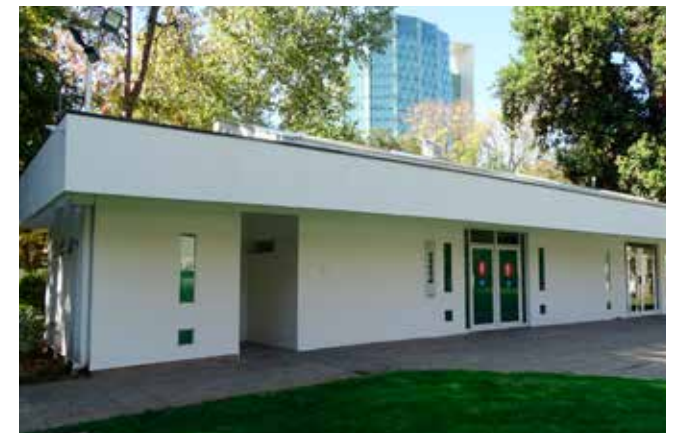
Remodelación de baños públicos y construcción de baños para personas con capacidades diferentes
