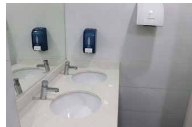
Remodelación de baños públicos
