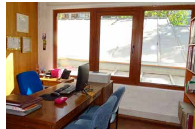
Instalación de ventanales de termopaneles. Segundo piso
