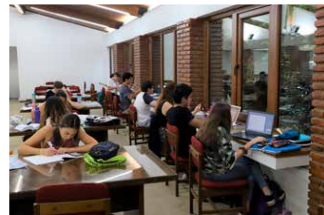
Instalación de ventanales de termopaneles. Sala de lectura
