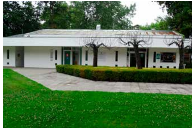
Remodelación pasillo circulación
