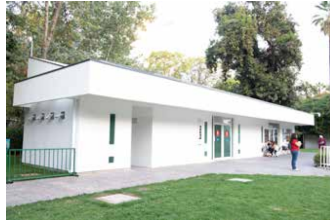
Pintura edificio cafetería y baños públicos
