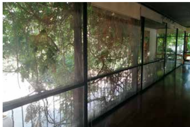
Instalación termopaneles Casona (antes)
