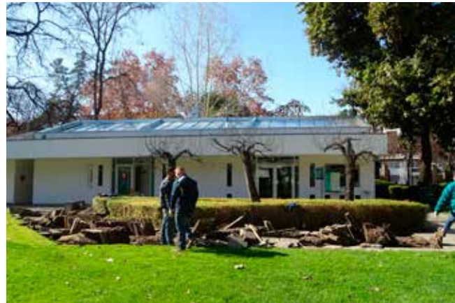
Remodelación pasillo circulación (antes)
