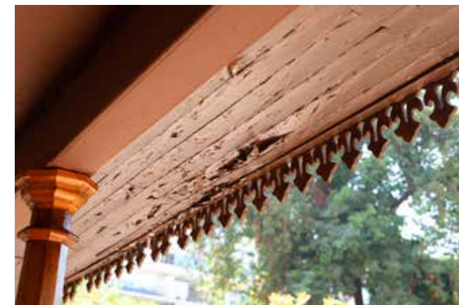
Pintura exterior Casona (antes)
