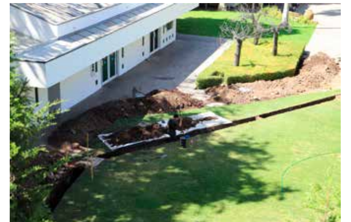
Nueva red alcantarillado
