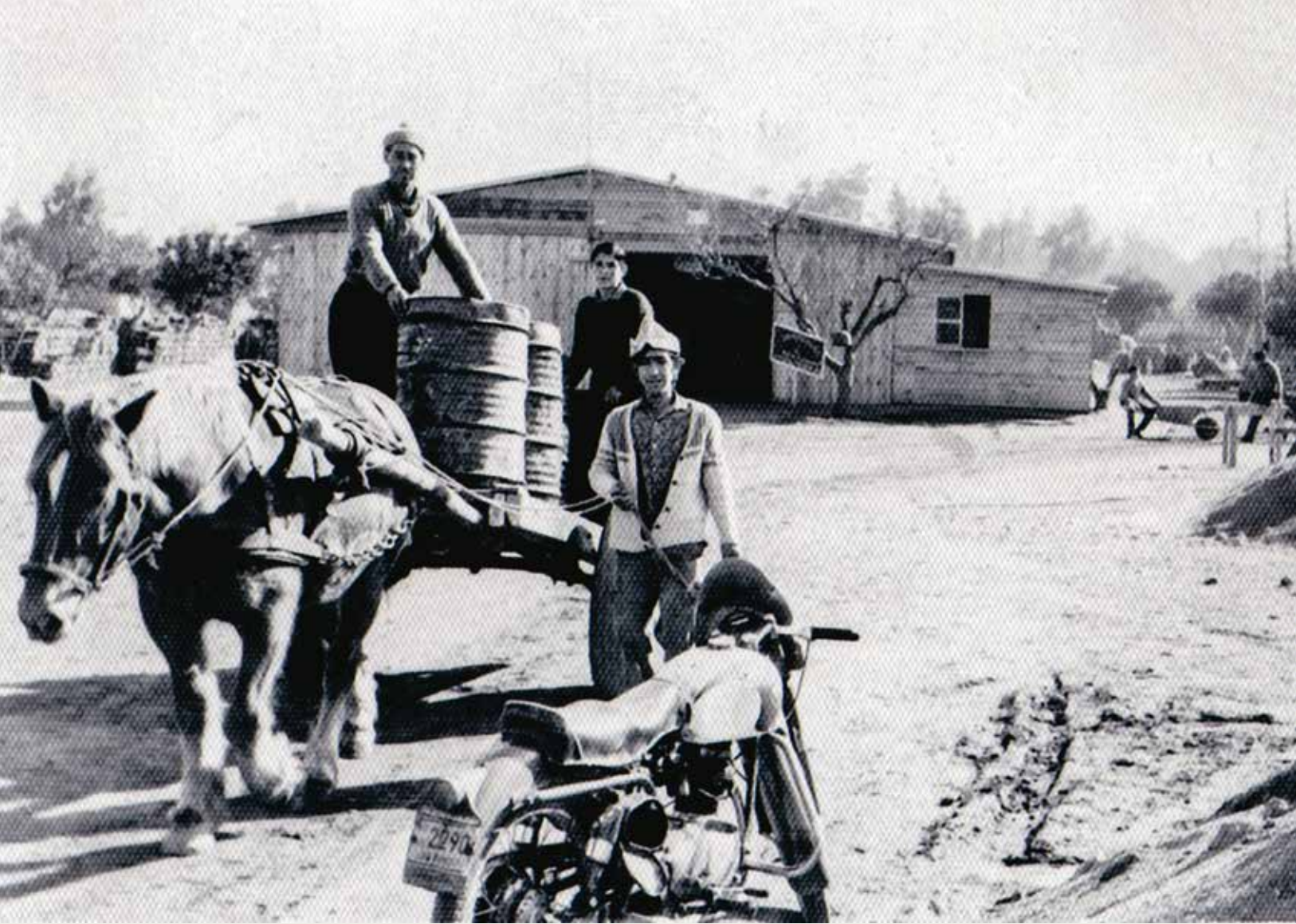
TÍTULO: Traslado de materiales para la construcción de casas de las cooperativas en la calle Patricia PROPIETARIO: Isabel Bravo Rivera AÑO: 1964 LUGAR: Las Cooperativas, Las Condes
